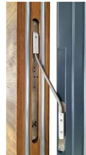
Steckbarer Kabelübergang mit analoger Steuereinheit. (im Türblattfalz montiert). Programmierung über die Tasten auf der Steuereinheit.
