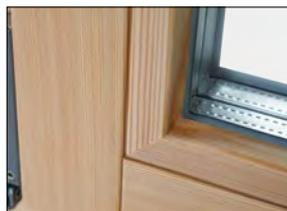
Ein komplett verdeckt verschraubter, lackierter und überfälzter Glasleistenrahmen sorgt für ein perfektes Design, erhöhte Dichtigkeit und Wärmedämmung im Glasfalzbereich.
