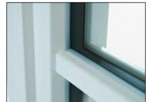
Filigrane Glasversiegelung innen und außen durch einen CNC-Automaten sorgt für eine formschönes Design und mehr Dichtheit.
