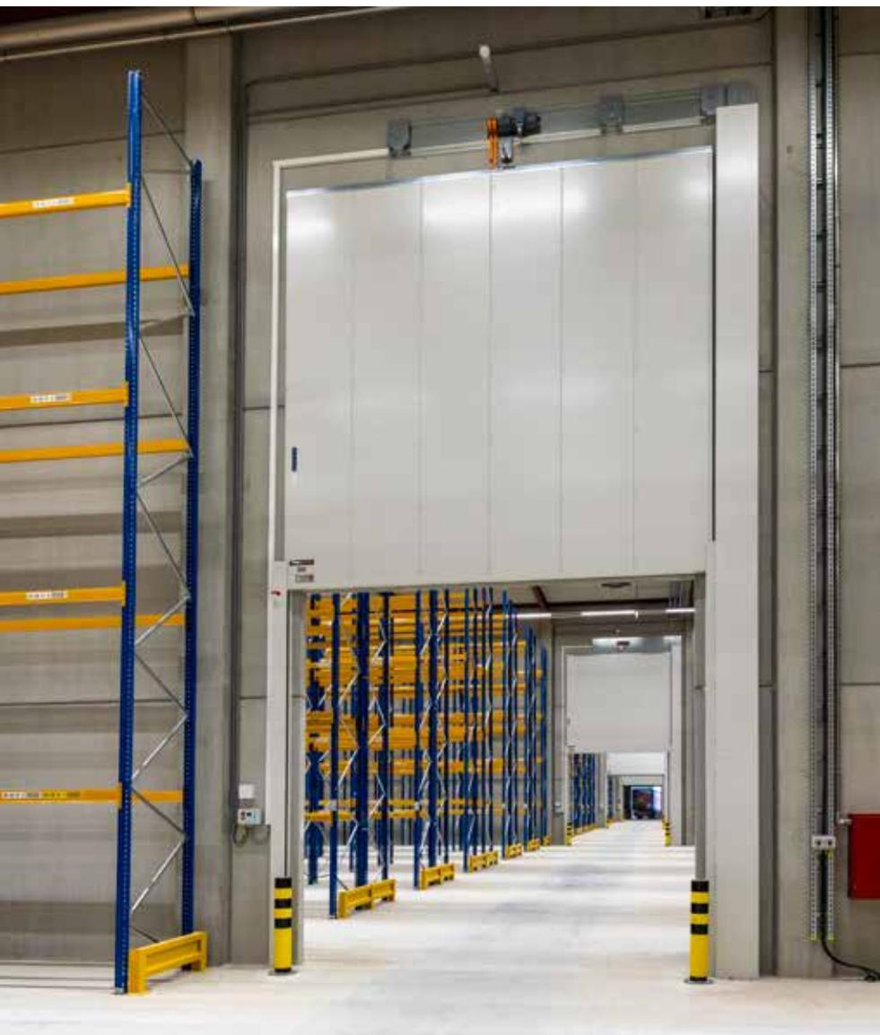
OBEN LINKS. Feuerschutz-Schiebetor FST 90-1 OD, 1-flügelig, Anthrazitgrau RAL 7016, Stahl-Objekttür H16-1 OD, Schnellauftr V 6030 SEL
