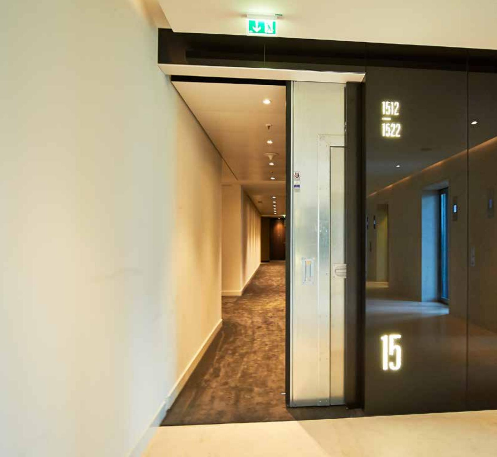
OBEN. Feuerschutz-Schiebetor FST 30-1 OD, 1-flügelig, stumpf auflaufend ohne Einlaufprofil, verzinkt
