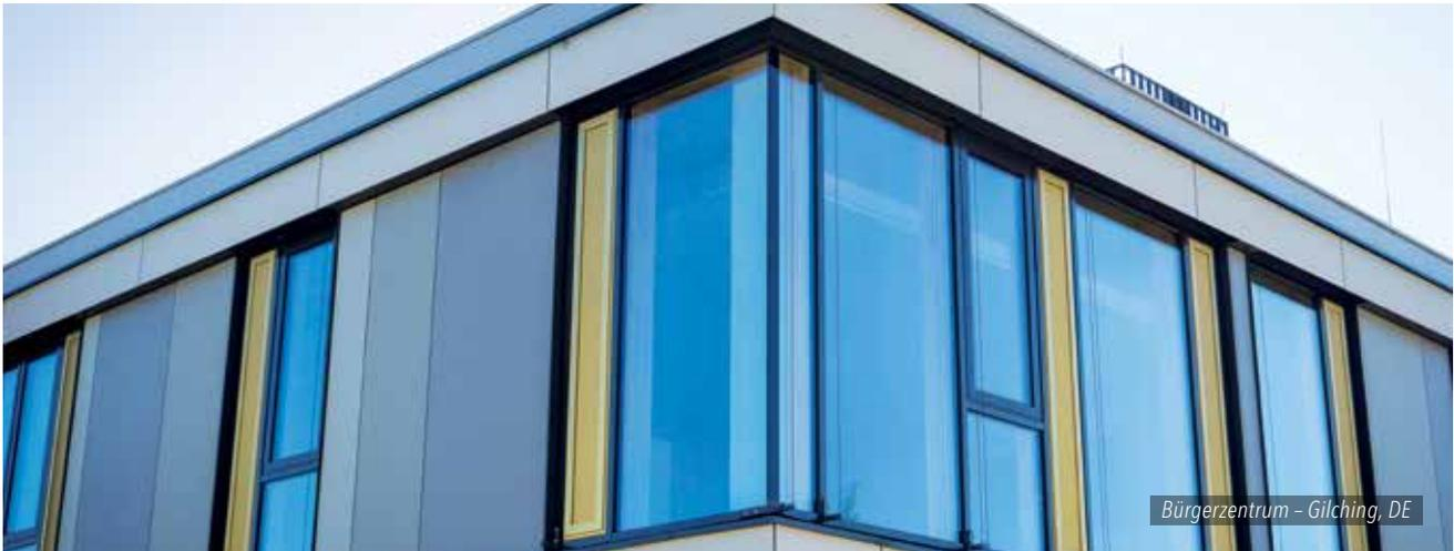
RAICO bietet zwei unterschiedliche Lüftungsklappen als Ergänzung für das Fassadensystem THERM<sup>+</sup> (Ansichtsbreite 200 mm) und das Fenstersystem FRAME<sup>+</sup> (Ansichtsbreite 300 mm) an. Die Lüftungsklappe ist ein außergewöhnliches gestalterisches Element und eignet sich zudem perfekt für die Nachtauskühlung von gewerblichen Gebäuden.
