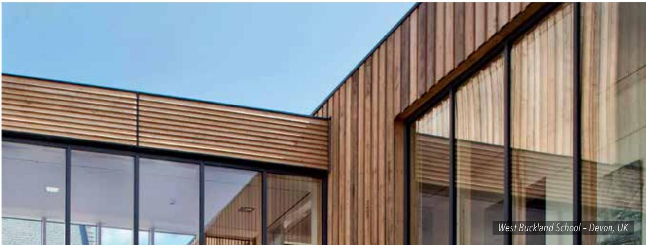
Bei dem innovativen Aluminium-Holz Integralfenster FRAME<sup>+</sup> 90 WB-T trifft warmes Wohnambiente auf modernste Verbundtechnologie aus hochwärmedämmendem THERMORIT. Erleben Sie Gemütlichkeit im Innenbereich durch den Rohstoff Holz und außen klassische Funktionalität dank witterungsbeständigem Aluminium.
