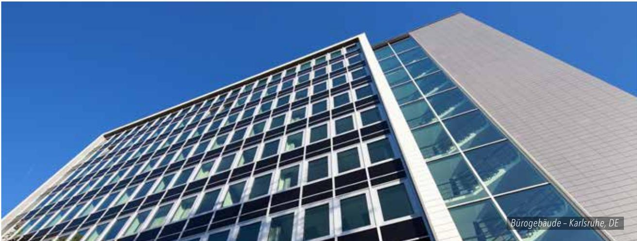
FRAME<sup>+</sup> mit filigranem Slim Design: Mit dem FRAME<sup>+</sup> 75 SF bieten wir Ihnen ein Fenstersystem mit extrem schlanker Optik. Die Ansichtsbreite der Außenansicht des Flügels von lediglich 23 Millimetern ermöglicht die Umsetzung zeitlos eleganter Architektur mit hochwertiger Detaillierung.
